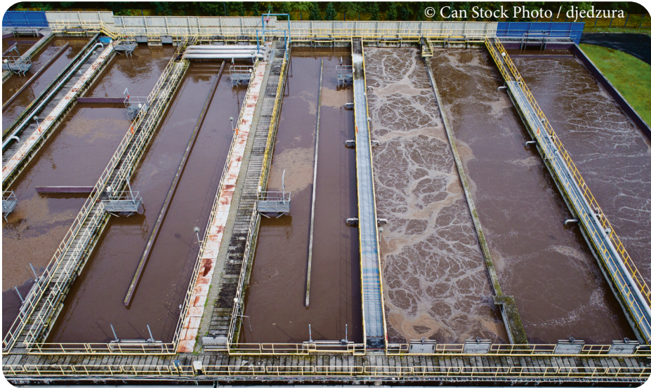
Het schoonmaken van vies afvalwater wordt gedaan met behulp van grote waterbakken waarin heel veel bacteriën leven.
